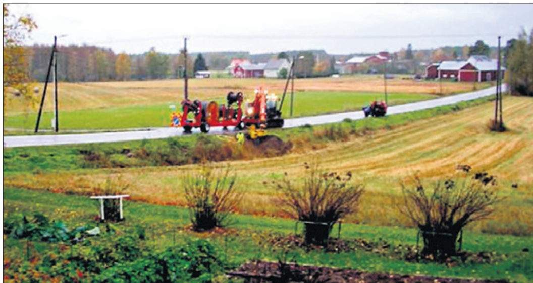
Flinck Jordbyggnad Ab jobbar med grävingsarbeten för fiberkabeln längs med Värnumvägen.
